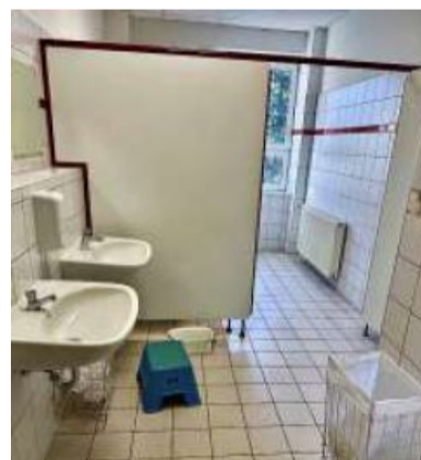
Die Sanitäranlagen werden ab Juni umfassend erneuert.
