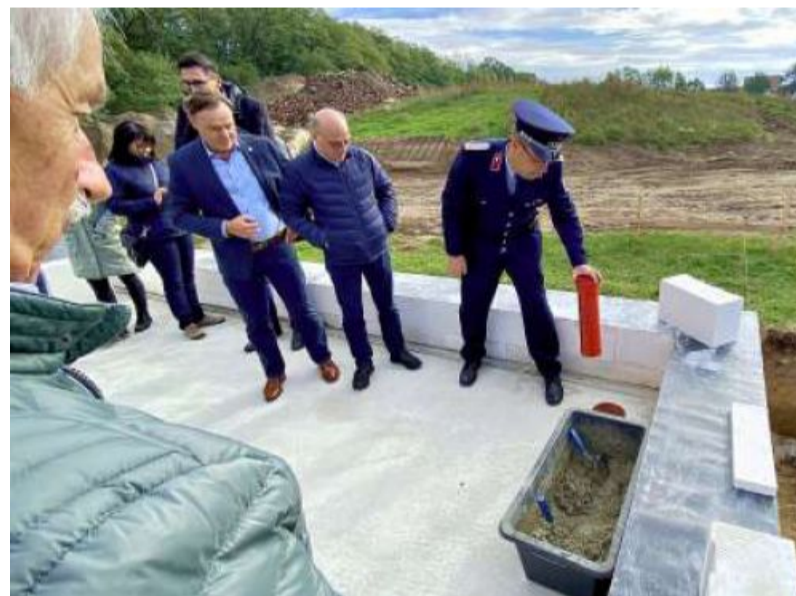
Klödens Wehrleiter Danilo Mölbitz versenkt die gefüllte Hülse ins Fundament.
