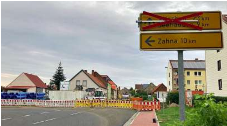
Der Abzweig nach Gadegast ist soweit fertig gestellt. Die Baustelle wandert jetzt von Süden nach Seyda hinein.
