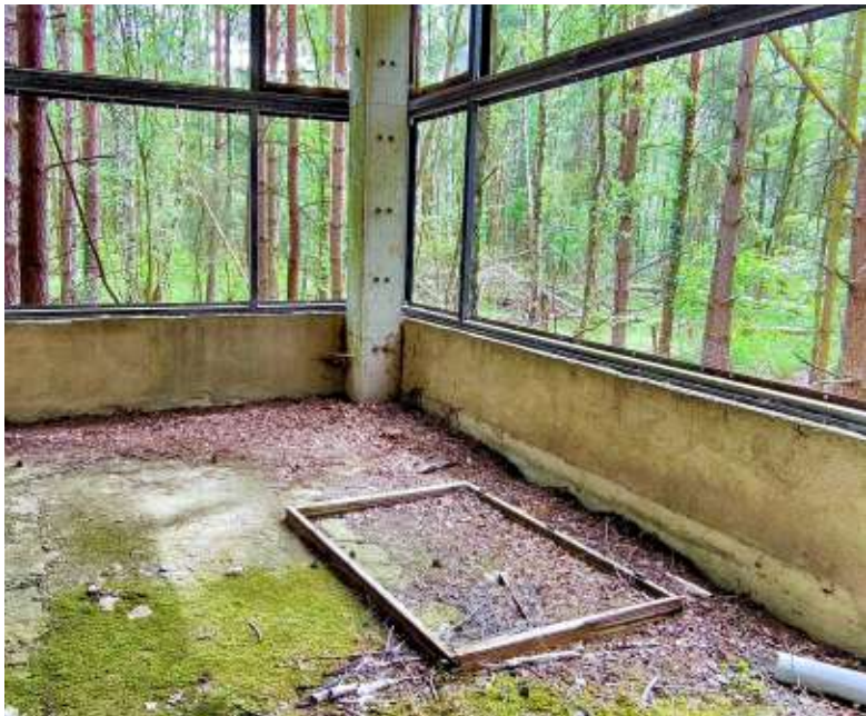
Fast 50 Jahre ist der Rohbau alt, den das Energiekombinat West errichtete.
