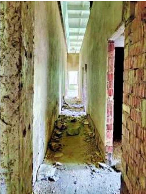
Lange, leere Flure durchziehen den Rohbau.
